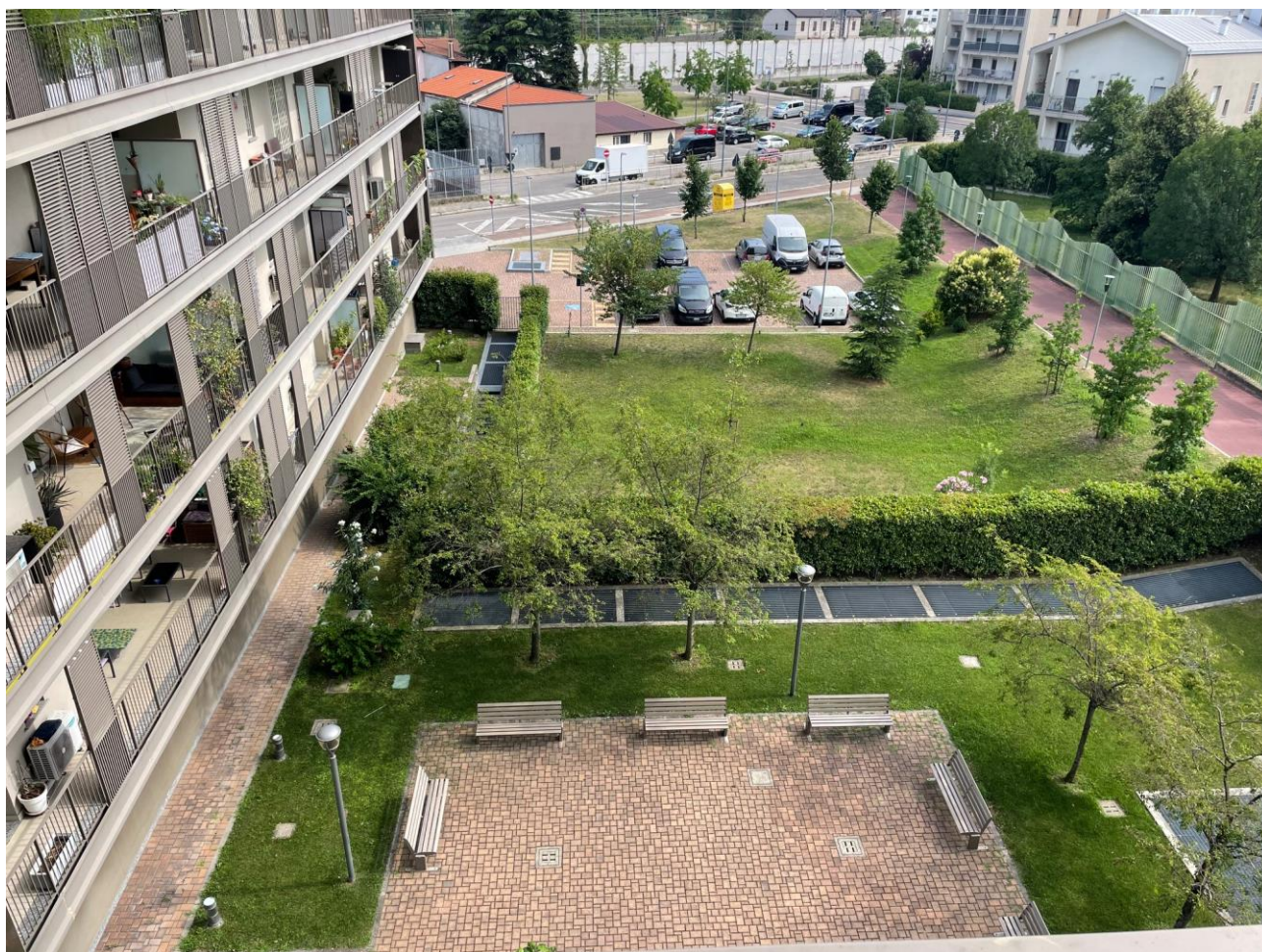
Vista del cortile interno
