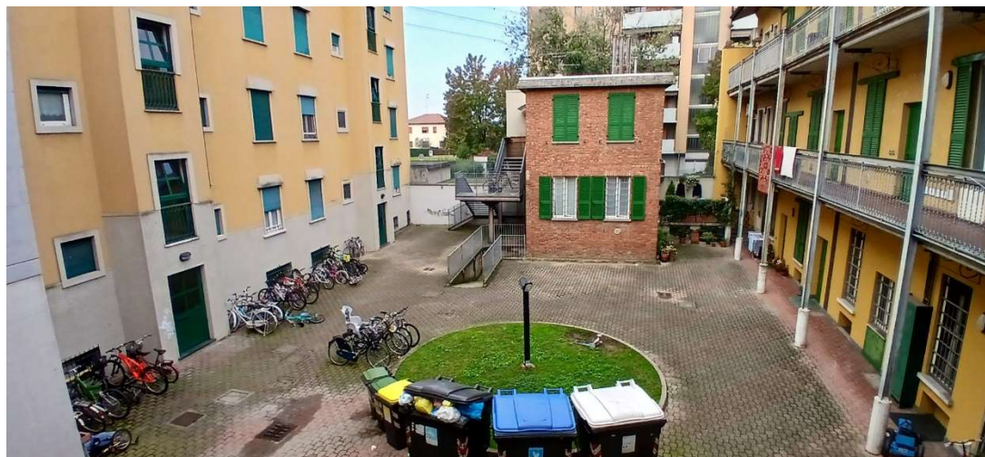
Vista del cortile interno
